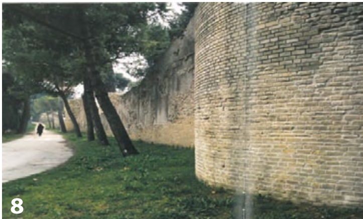
(Fig. 8-9_ Le mura al termine del restauro).
